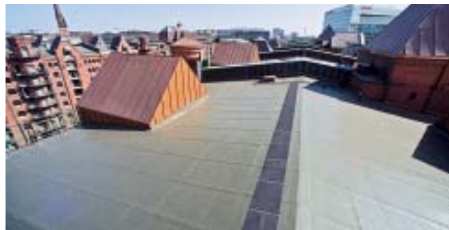
Dachabdichtung: Neben der reinen Materialfrage spielte auch die Farbgebung eine wesentliche Rolle.
